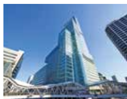
あべのハルカス ・大阪メトロ御堂筋線 「心斎橋」駅→「天王寺」駅 (約8分)
